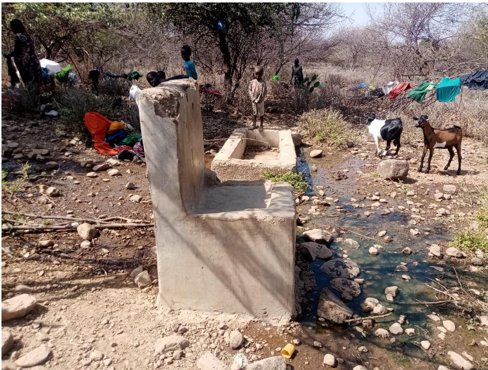
Foto 14. Lavatoio e abbeveratoio del villaggio, in disuso
