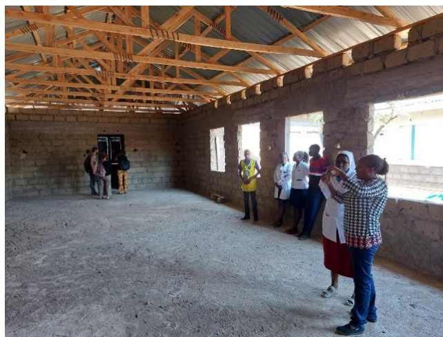
Foto 11. Ala di maternità da completare
